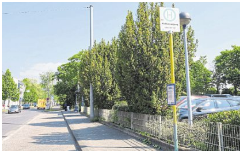
Die Haltestelle Kraftversorgung an der Friedrich-Ebert-Straße ist eine von acht Haltestellen, die nun barrierefrei umgebaut werden. Foto: Stadt Neuwied
